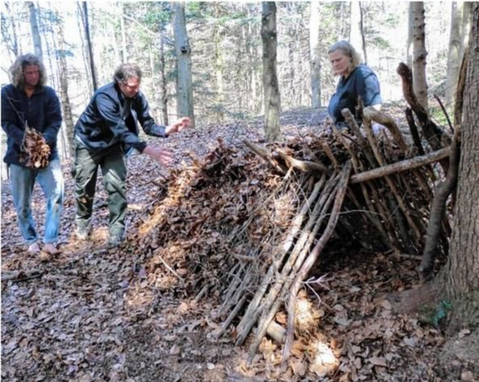
Die Laubhütte bietet Schutz vor Kälte und Regen. Für den Bau werden keine Werkzeuge benötigt, das Material liefert der Wald.
